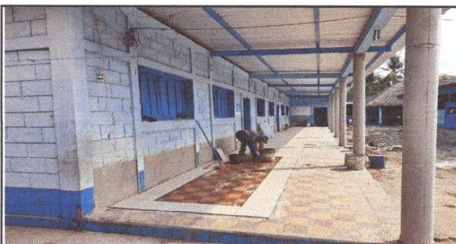
Foto 5: Sellado de grietas y fisuras en muros y columnas de 3 aulas y dirección, sustitución de lamina por lamina troquelada calibre 26 y soporte de metal
