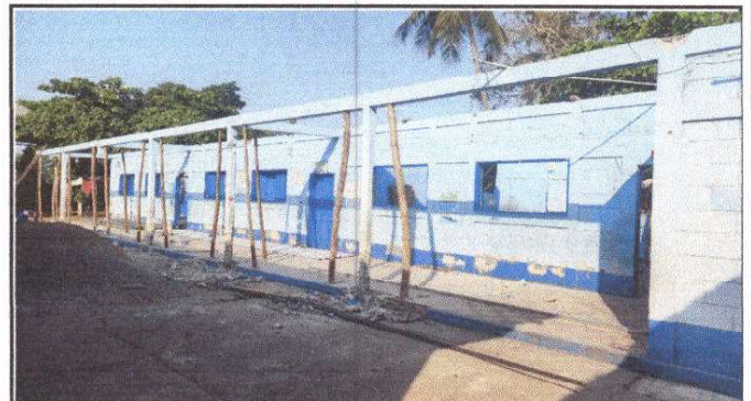
Foto 4: Sellado de grietas y fisuras en muros y columnas de 3 aulas y dirección, sustitución de lamina por lamina troquelada calibre 26 y soporte de metal
